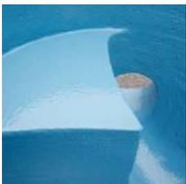
Resinatura con sistema Scudotec ad alta resistenza chimica al fine di preservare il calcestruzzo dall'attacco di sostanze quali cloruri, solfati, idrocarburi, tensioattivi, acidi e alcali.
